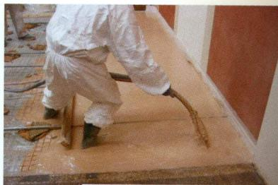
2<sup>a</sup> Fase di posa in opera del massetto in cocciopesto MGN: è precisa e veloce. Le fascette di quota ne determinano il livello e la posa mediante macchina intonacatrice ne riduce notevolmente i tempi di stesura.
