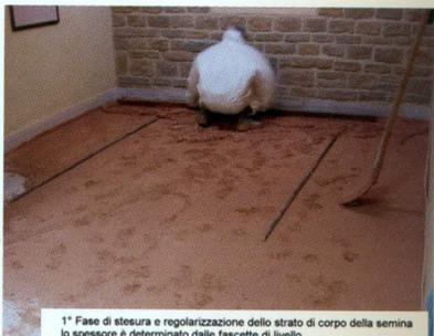
1<sup>a</sup> Fase di stesura e regolazione dello strato di corpo della semina: lo spessore è determinato dalle fascette di livello.
