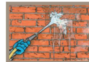
**2.** Lavaggio accurato della superficie da trattare con getto d'acqua a pressione, al fine di asportare le parti mobili e sali residui in superficie.
