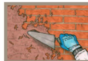
**3.** Applicare l'intonaco di RINZAFFO a copertura totale del supporto, in andamento alla muratura, con spessore minimo di 5 mm.
