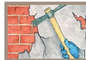
**1.** Demolizione accurata dell'intonaco ammalorato circa 1 metro sopra la parte degradata, rimozione dei materiali non compatibili
