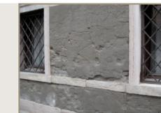
1 Intonaco danneggiato da acqua e sali. Analisi delle cause e rilievo delle quote di risalita dell'umidità.
