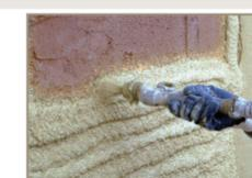
8 Dopo aver inumidito correttamente il supporto (in qualsiasi stagione e condizione meteorologica) si potrà procedere con l'applicazione a due passaggi (manuale/meccanica) dell'intonaco Risanamur B-80 Evolution.
