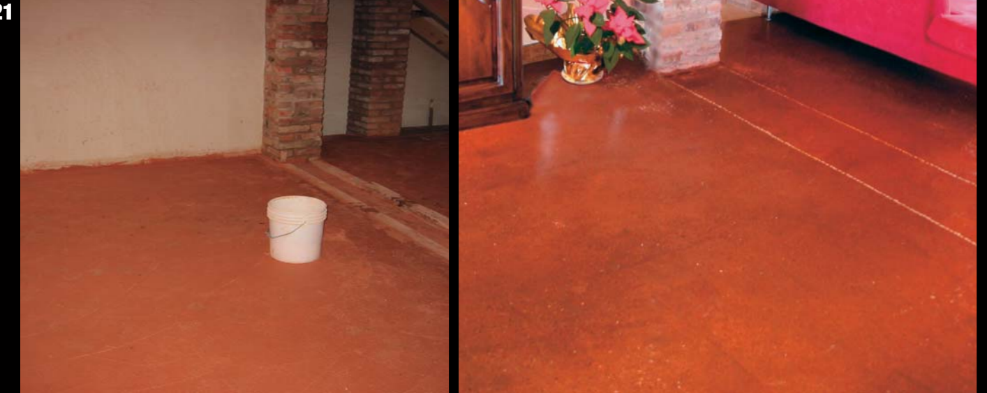
Foto 18-19-20-21-22 Nelle foto qui riportate si vedono le fasi di preparazione e di realizzazione dei massetti sui solai in legno. Per esaltare e rendere più unico il confort abitativo sono stati realizzati solo massetti in cocciopesto MGN.
