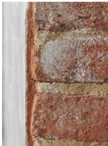
Figura 13: Scorcio del muro 1 fronte A, riquadro 1; vista laterale per evidenziare gli spessori relativi a due passaggi per ottenere un intonaco in sabbia monostrato (foto L. Scappin)
