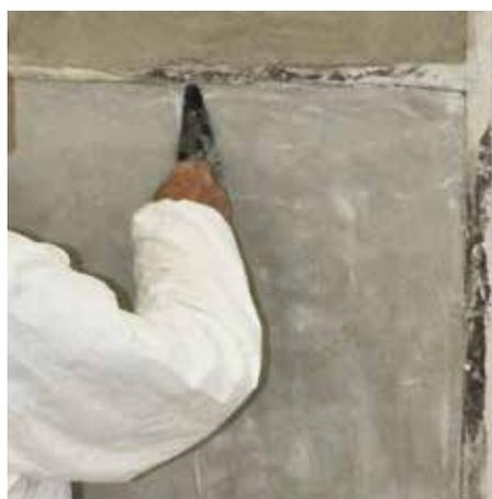
Figura 8: Muro 1, fronte A, pannello 1; fase di pressatura e lisciatura con frattazzo in legno del secondo e ultimo passaggio (foto L. Scappin)
