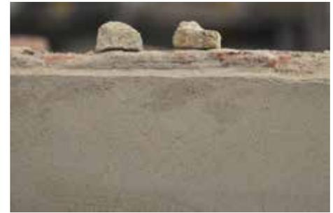
Figura 12: Particolare del muro 1 fronte A, riquadro 2; confronto tra campione di intonaco, visto in sezione, nei due frammenti appoggiati sopra il pannello murario, e l'intonaco riprodotto, con finitura a lisciatura (foto L. Scappin)
