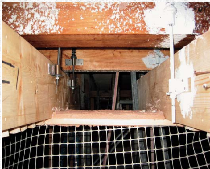
8/9/10 Ben visibile in queste foto la sezione della volta intonacata.
