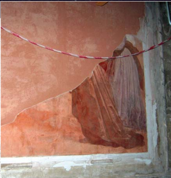
19/20/21 Nelle foto possiamo vedere la prima fase di intonacatura interna del teatro. Tale lavorazione è stata realizzata tramite stesura di intonaco a cocciopesto MGN.
