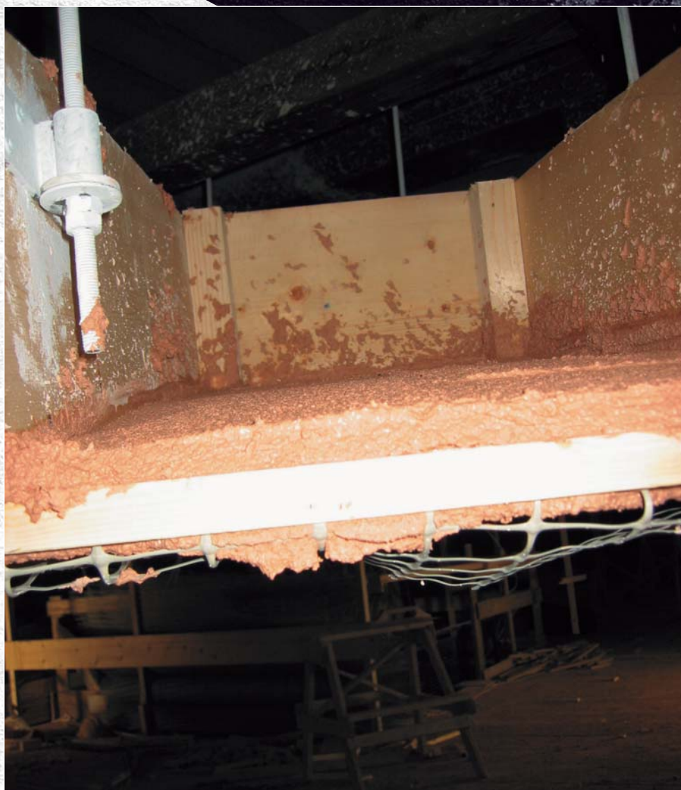
8/9/10 Ben visibile in queste foto la sezione della volta intonacata.
